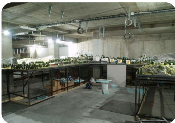
Kolejiště K2 ve výstavbě
