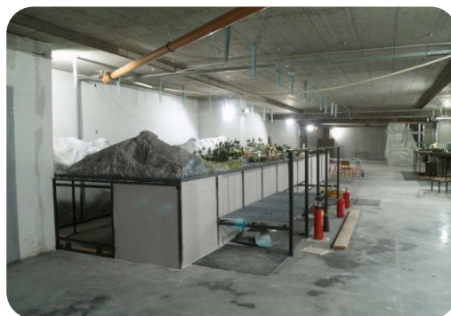
Kolejiště K1 ve výstavbě
