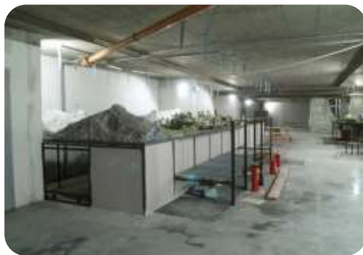
Kolejiště K1 ve výstavbě
