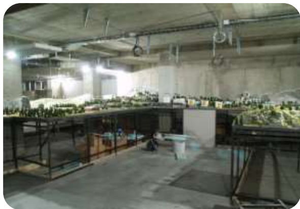
Kolejiště K2 ve výstavbě
